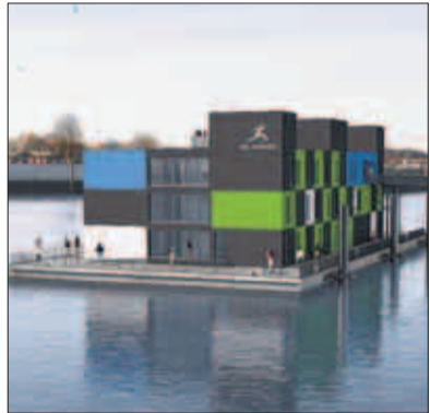
Das IBA-Dock am Muggenburger Zollhafen dient ab 2010 als schwimmendes Ausstellungs- und Bürogebäude. Es besteht aus Modulen. SIMULATION: SLAWIK/ IBA HAMBURG
